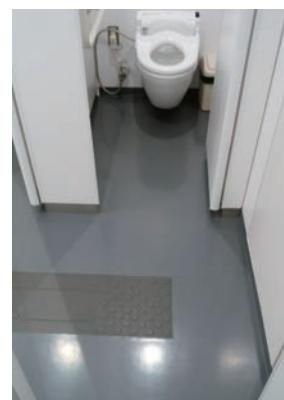
2Fトイレ入口。入ってすぐに左折しなければならないため、床の低突起型点字ブロックが効果を発揮している。
