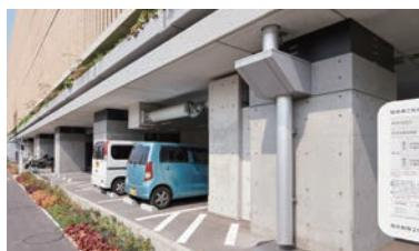
上：北東からの外観。生涯学習センター(メディアパーク市川)とリンクした煉瓦スクリーンが東・西面のファサードを彩る。左：地震時のBCP(事業継続性)を考慮し、上階を支える1Fの柱頭部には免振装置が設置されている。
