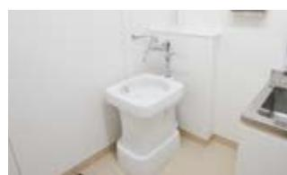
一つの病棟に必ず一つの汚物室を設け、レバーハンドルで水はねの少ない新型の汚物流しを導入している。
