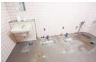
工事中のトイレ内部。床も新しく張り替えたが、壁面はそのまま残している。
