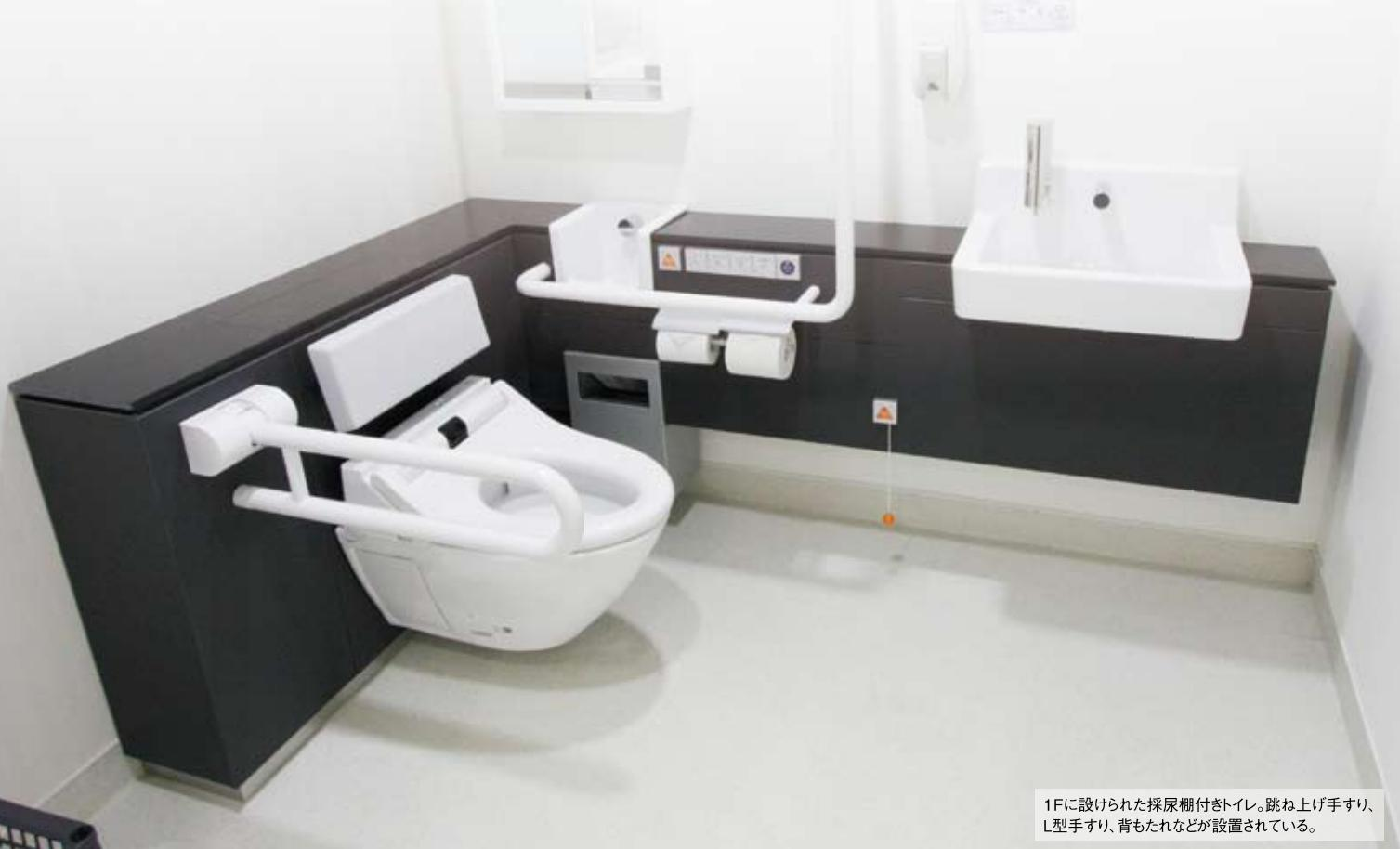
1Fに設けられた採尿棚付きトイレ。跳ね上げ手すり、L型手すり、背もたれなどが設置されている。
