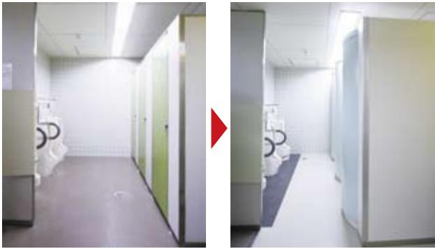
床も湿式から乾式に変え、段差が解消されてバリアフリーに。湿式の時は、水で滑ってしまうことが転倒の原因にもなっていました。
