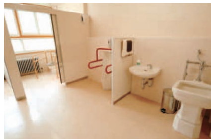
床・壁がタイル張りから表面塗装となり、温かみのある表情になった。
