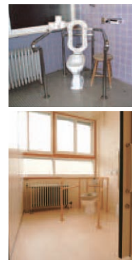
両脇から介護できるトイレも内装が変わり、便器や補助具も新しくなり、ソフト便座や、2段式手すりなどもついて快適に。(上の写真は改装前)
