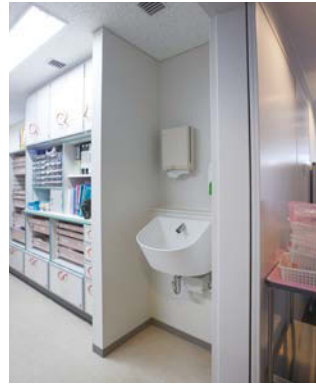
ナースステーション入口に設けられた、水はねに配慮し清潔さを保つスタップ用手洗器。
