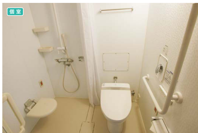
個室のトイレ・シャワーユニットには、L型手すりやI型手すりのほか、シャワー時に腰掛けられる、跳ね上げ式のスツールも設けられている。
