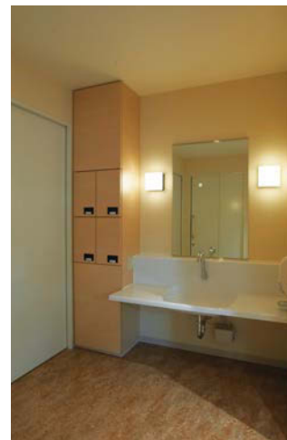
小児病棟の4床室の、高さ600mmの洗面台。
