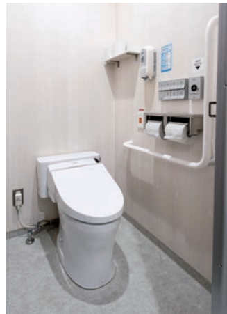
トイレのブースにはL型手すりを採用。左右勝手にも配慮されている。
