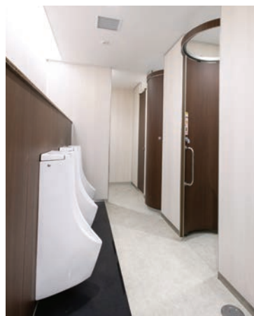
外来管理診療棟4Fの男性用トイレには、アール型扉のトイレブースを採用している。
