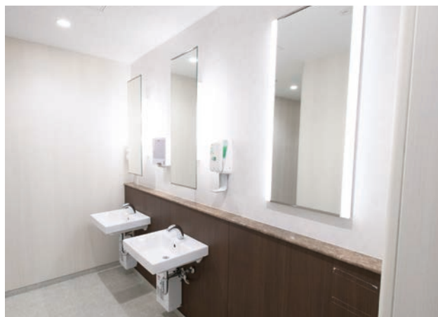
4Fのスタッフエリアの女性用トイレには、スタイリングコーナーを新設。非接触で節水にもつながらる自動水栓を採用し、鏡の後ろに照明を設置して明るい空間にしている。
