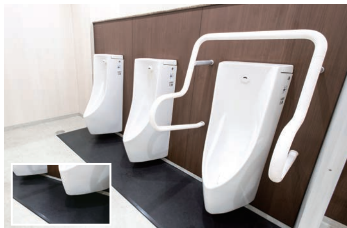
男性用トイレの小便器は、清掃のしやすい壁掛けタイプ。小便器下には、経年劣化を防ぐために防汚防臭陶板が採用された。
