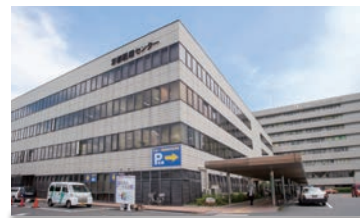
建物は外来管理診療棟、中央診療棟、病棟など、複数の棟で構成されている。
