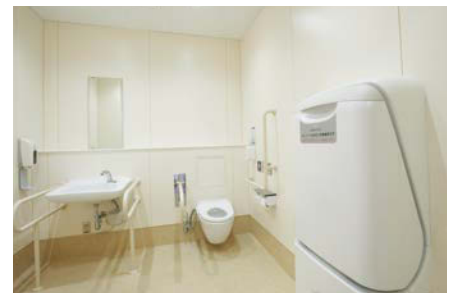
1F外来の多目的トイレ。壁掛け便器、巻上巾木など、汚れても清掃のしやすい空間になっている。
