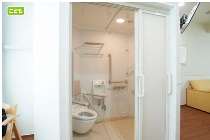
小児病棟の個室に設けられた、八角形のトイレ・シャワー空間。壁の直角をなくすことで見通しがよくなるとともに、ベッドの移動もスムーズにできる。
