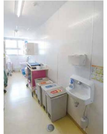
3F A病棟に設けられた汚物処理室。出入口近くに手洗器、奥に汚物流しが設置されている。
