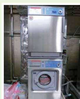
▲清掃用資材専用の熱水洗濯乾燥機
