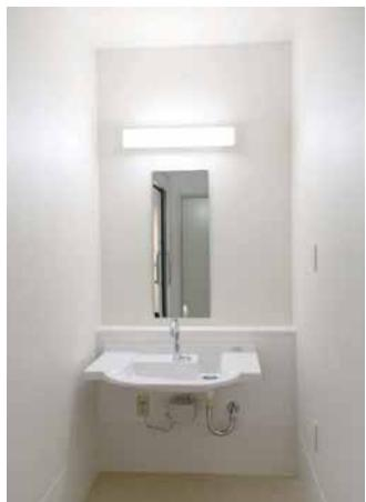
4床室の洗面カウンターは、カウンター横に入って介助ができるように、片側に十分なスペースを確保。また、カウンターの側面もしっかりと清掃できるよう、あえて壁との間に隙間を設けて設置している。
