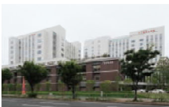
品格あふれる低層部と、そびえ立つツインタワー。周辺の街並みとの調和がはかられている。
