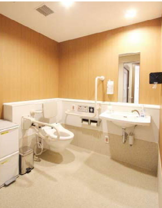
4床室のトイレは、車いすで利用できる広さを確保。座位の安定のために背もたれを設置し、汚れがたまりにくい巻上巾木を採用。
