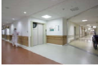
新診療棟と北病棟との接続部分。
