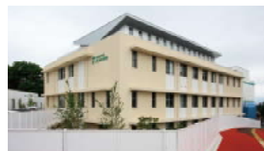
起伏のある地形を生かして建てられた新・診療棟。奥に見えるのが従来からの病棟。
