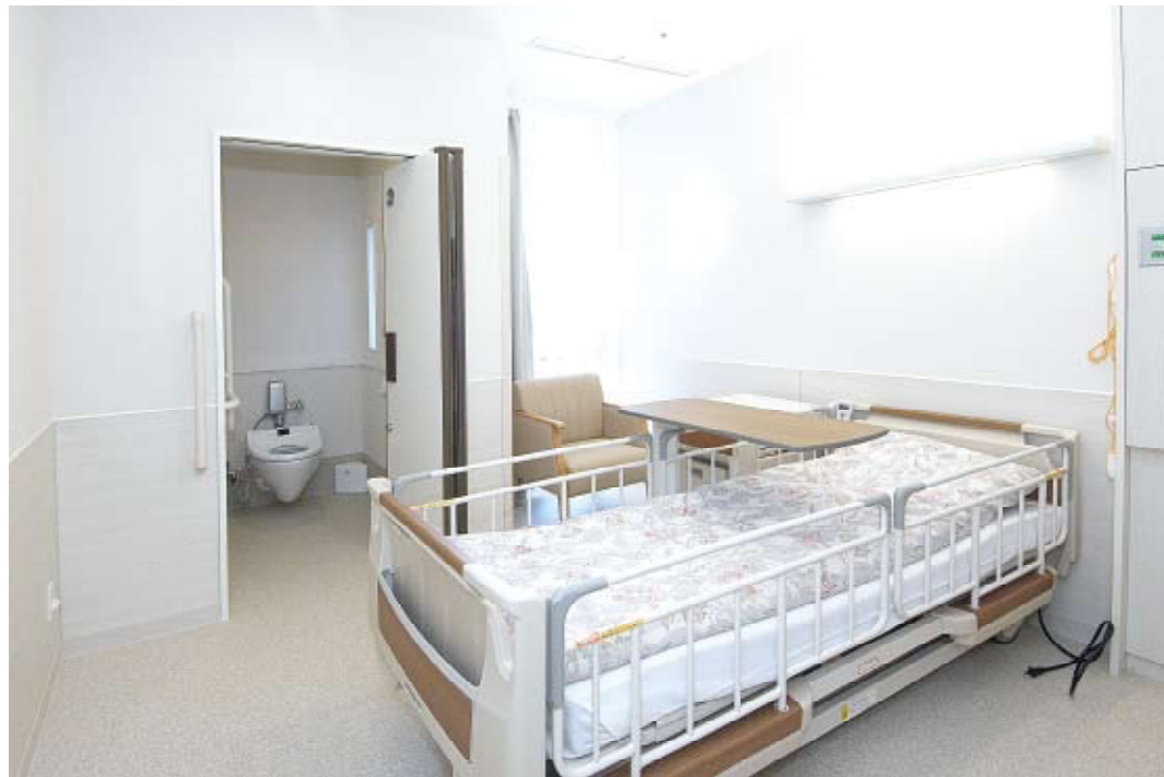
トイレの扉はマルチ折戸で、体を預けるだけでスムーズに開くバリアフリー設計。手すりの位置や間口の広さは介助しやすいように考えられている。
