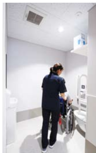
老人保健施設の個室のトイレ。すべてを保護しなくてもよいという判断で、背もたれは設置していない。必要以上の手すりはいらぬという意見もあり、手前は跳ね上げ式を採用している。
