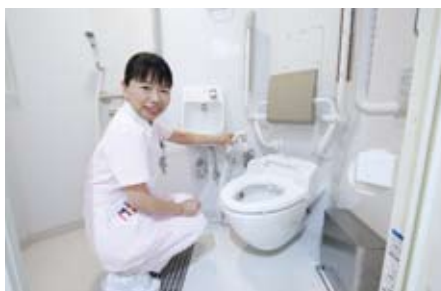
尿瓶などを洗うために使う専用のシャワーも設けられている。
