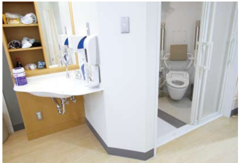
出入り口には段差のない3枚引戸を採用。洗面台を使用する場合のアプローチもスムーズである。
