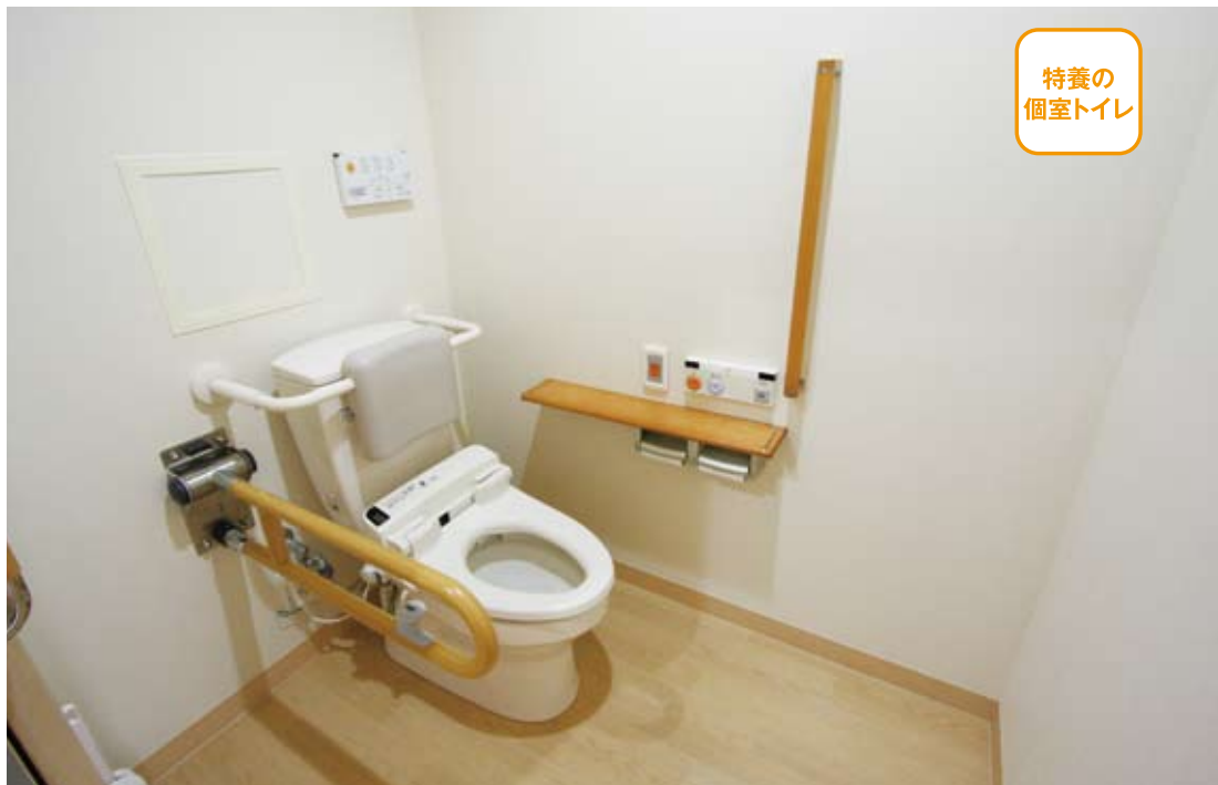
「藤沢愛光園」の個室のトイレ。跳ね上げ手すり、I型手すり、背もたれを採用している。ボタンが大きなリモコンは入居者の方もわかりやすいように「流す」「おしり」「止」とシンプルなもの。
