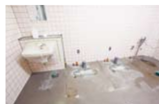
工事中のトイレ内部。床も新しく張り替えたが、壁面はそのまま残している。
