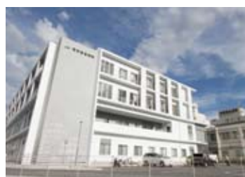
左側の4階建ての建物が、新しく建てられた本館。制震構造を採用している。
