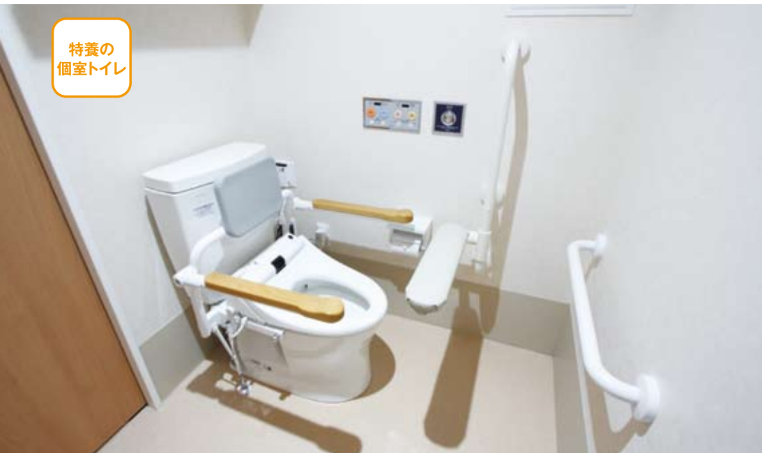
特別養護老人ホームの個室のトイレ。介護老人保健施設とは異なり、前方アームレストやアームレスト、背もたれなどを採用している。特養では座位の保持、老健では立位の保持に重きを置いたと言える。
