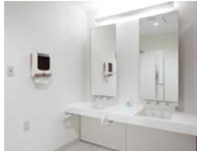
1F外来にある女性用トイレの洗面カウンター。質感と手洗いのしやすさにこだわった洗面器を採用している。
