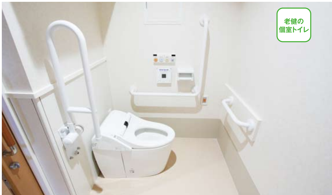
老人保健施設の個室のトイレ。すべてを保護しなくてもよいという判断で、背もたれは設置していない。必要以上の手すりはいらぬという意見もあり、手前は跳ね上げ式を採用している。
