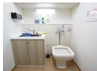
各フロアに1ヵ所ずつ設けられている汚物処理室。流しでは尿器を洗ったりする。
