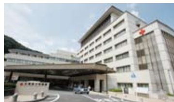
10階建てのいちばん高い建物が、今回改修を行った1号棟である。
