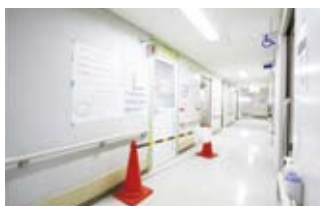
工事中の廊下。スピーディーな工事のため、使えない期間はごくわずかである。
