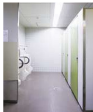
床も湿式から乾式に変え、段差が解消されてバリアフリーに。湿式の時は、水で滑ってしまうことが転倒の原因にもなっていた。
