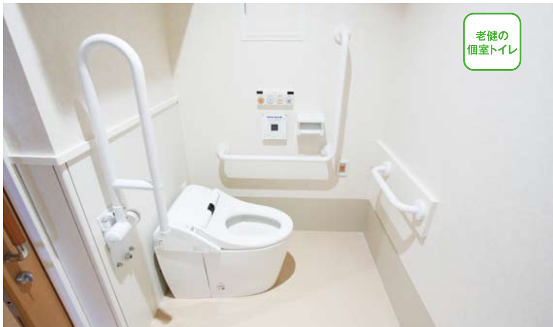
老人保健施設の個室のトイレ。すべてを保護しなくてもよいという判断で、背もたれは設置していない。必要以上の手すりはいらぬという意見もあり、手前は跳ね上げ式を採用している。
