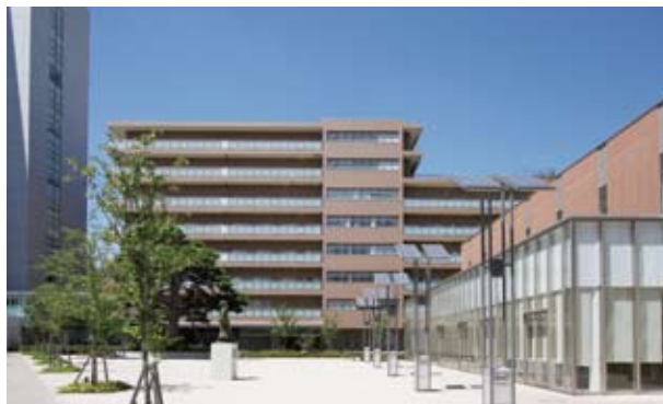
総合福祉センターの外観。左に見えるのは医療センター。
