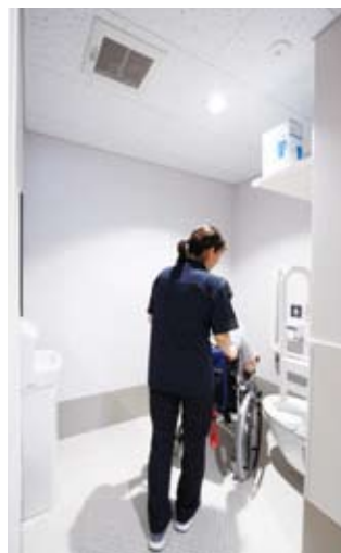
老人保健施設の個室のトイレ。すべてを保護しなくてもよいという判断で、背もたれは設置していない。必要以上の手すりはいらぬという意見もあり、手前は跳ね上げ式を採用している。
