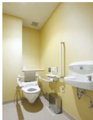
4床室のトイレ。リハビリのためにも跳ね上げ手すりがよいと考えられた。壁の色は、患者さんを元気づける明るいイエロー。
