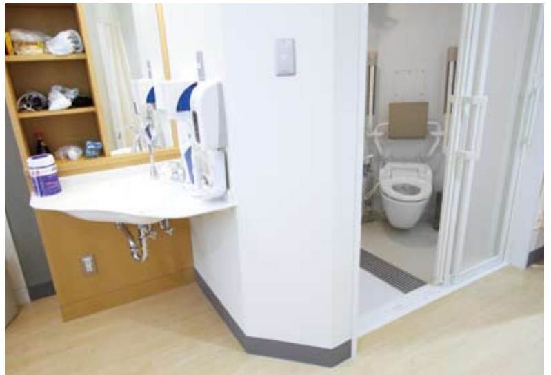
出入り口には段差のない3枚引戸を採用。洗面台を使用する場合のアプローチもスムーズである。
