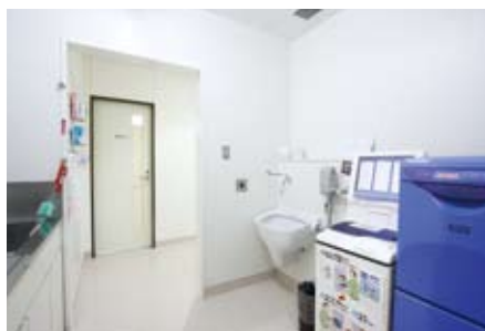
汚物室には、コンパクトで水はねの少ない汚物流しを設置。尿が見えず臭いの問題を解消する蓄尿器も置かれている。左奥が検尿用トイレ。
