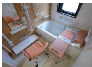
ユニット館に設けられた浴室。入浴は基本的に個浴とし、個のやすらぎを大切にしている。
