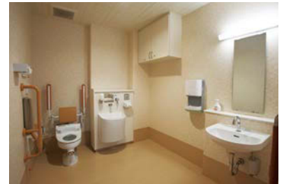
1Fの多機能トイレ。紙巻器が高い位置にもあるのは、介助者が利用者の目の前でペーパーを取らず、腰の負担にもならない、細やかな気配りの一つである。
