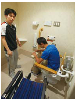
前方アームレストは、座位を安定させるためにも効果的である。
