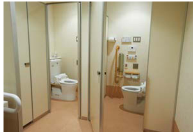
1Fの女性用トイレ。左右勝手どちらにでも対応できるよう、便器の向きが逆になっている。巻上巾木で清掃のしやすさにも配慮している。
