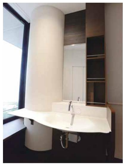
車いすでも使いやすい洗面台を、個室の窓側に配置。水栓が壁付けになっているので、水栓の付け根に水がたまらず、衛生的である。
