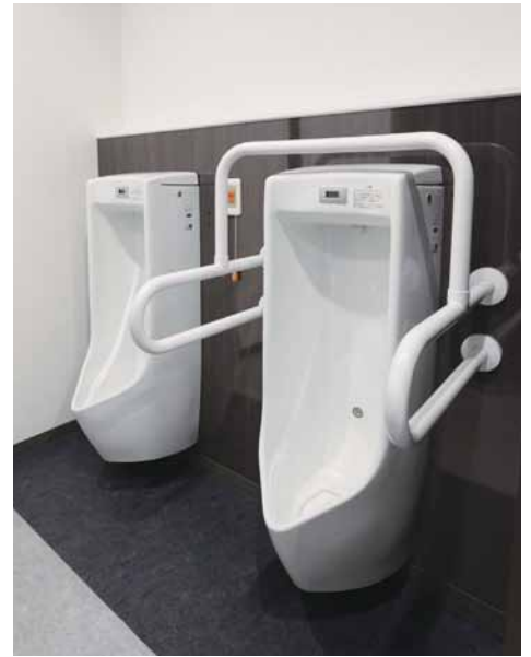
小便器の下には衛生性を高めるため、耐酸性のある長尺シートが敷かれている。
