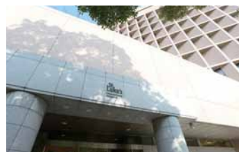
建物は本館と旧館から構成されている。
