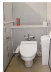
改修前のトイレ
