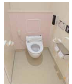
2Fの女性用トイレ。コンセントカバーが設けられている。
