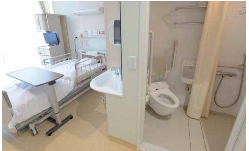
病棟の個室に設けられた8角形のトイレ・シャワーユニット。斜めの壁面を利用して手洗器が設けられている。
