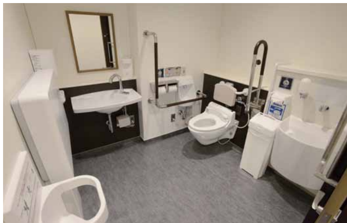
外来の「だれでもトイレ」。便器や手洗器の白色が際立つように、壁には濃い色を配している。
