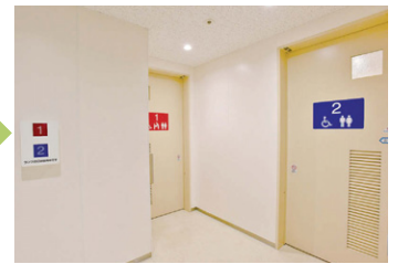
After 多機能トイレ出入口
