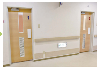
After 出入口外観とサイン
