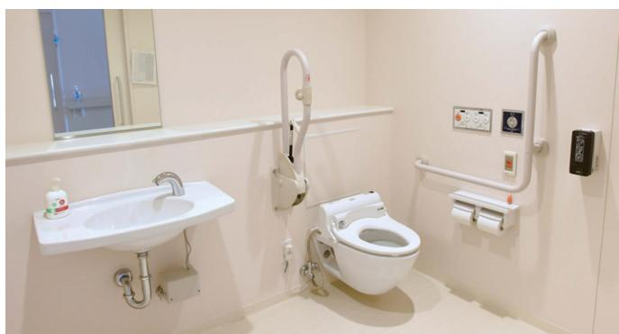
病棟10Fの車いすトイレ。便器は壁掛けタイプで、跳ね上げ手すり、L型手すりが設けられている。
