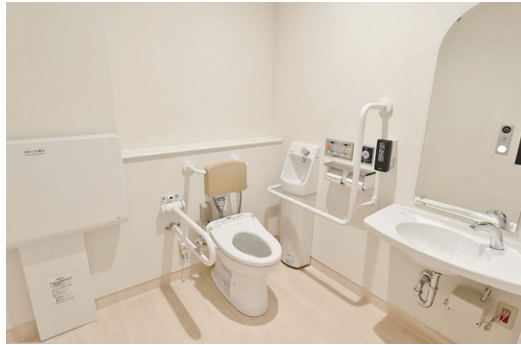
おむつ交換台などが設けられ、巻上り巾木を採用している外来の多機能トイレ。
