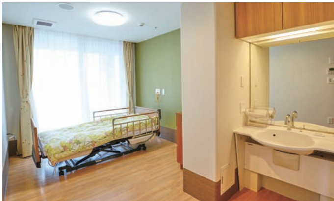
窓が広く明るい個室。車いすでも使いやすい洗面カウンターが設けられている。なお、施設内の床には、転倒対策としてクッション性のある長尺シートを採用している。
