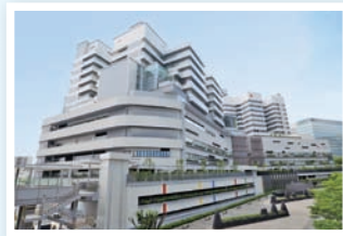
建物は13階建ての免震構造。右に隣接しているのが、さいたま赤十字病院。
