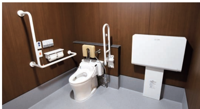
1Fの多機能トイレには、パウチ・しびん洗浄水栓付き背もたれ、おむつ交換台などが設置されている。
