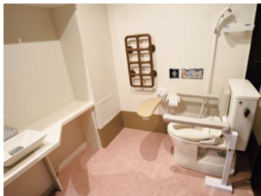
お風呂の脱衣室側と廊下側の2つのアプローチがあり、通常は廊下から、入浴時は脱衣室から使えるトイレ。大便器の掃除口は便利に使われている。
