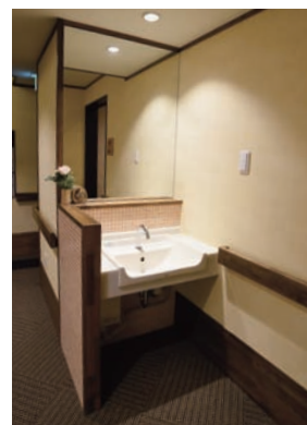
廊下に設けられた車イスでも使いやすい洗面カウンター。
