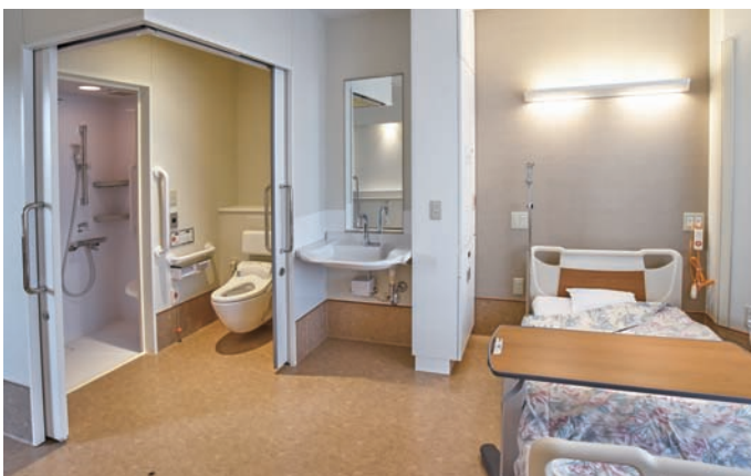
4F病棟の角部屋の個室は、トイレとシャワーが分かれている。車いすで便器の近くまでアプローチできて介助しやすい。
