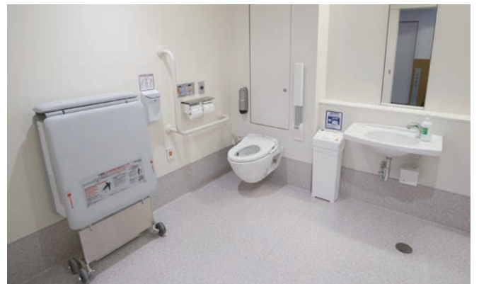
外来の多機能トイレは十分な広さを確保し、おむつ交換、衣類の着脱にも使用できる折りたたみシートなどを設けている。
