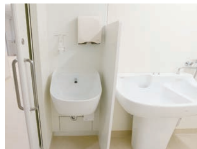
乳児バスの横には、スタッフ用手洗器の水はねを防ぐパーティションを設けている。
