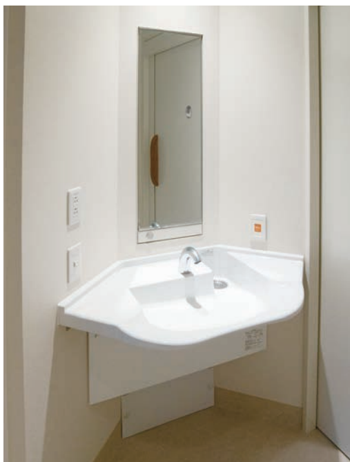
4F精神科病棟の個室に、スペースを効率的に生かして設けられた洗面器。車いすでも使いやすい仕様である。
