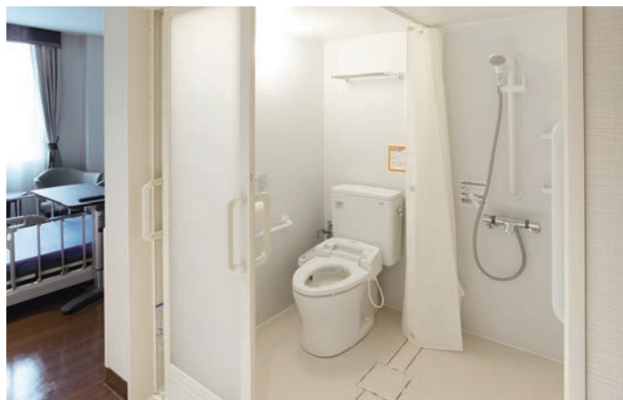
シャワー付きの個室。出入口が段差のないバリアフリー仕様になっている。
