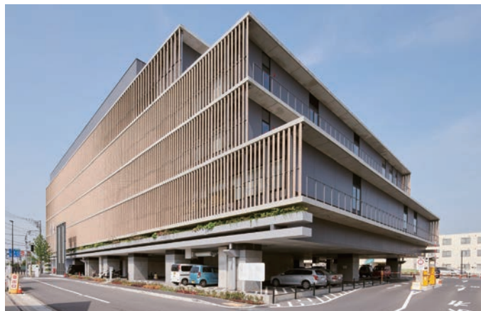
上:北東からの外観。生涯学習センター(メディアパーク市川)とリンクした煉瓦スクリーンが東・西面のファサードを彩る。左:地震時のBCP(事業継続性)を考慮し、上階を支える1Fの柱頭部には免振装置が設置されている。
