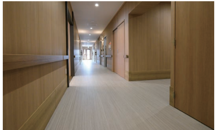
リノリウム床材を採用した一番館の廊下。耐久性に優れ、メンテナンスも容易である。
