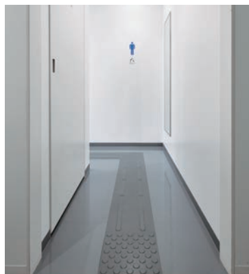
2Fトイレ入口。入ってすぐに左折しなければならないため、床の低突起型点字ブロックが効果を発揮している。
