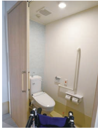
一番館の居室内のトイレ。入口は3枚引戸で、車いすでも楽にアプローチできる広さを確保。
