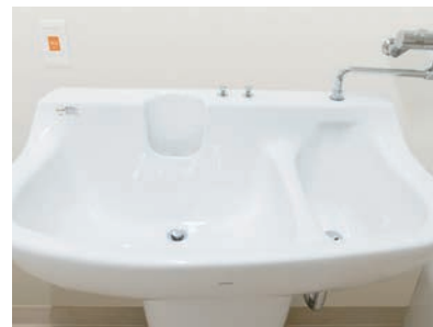
オーバーフロー穴をなくした乳児バス。オーバーフロー槽はしっかり洗える大きさがある。
