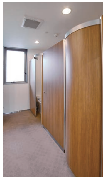
以前とレイアウトは変えずにアール型扉のトイレブースへリニューアルした、1Fの男性用トイレ。
