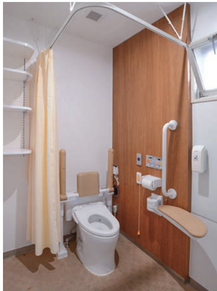
カーテンで仕切れるトイレブースには、スイングタイプ前方ボードやはね上げ手すり、背もたれなどが備えられている。
