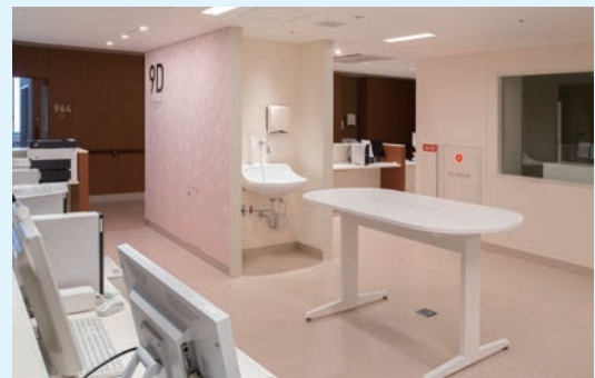
スタッフステーションの出入口の2ヵ所には、肘までしっかりと洗える大型の手洗器を設けている。
