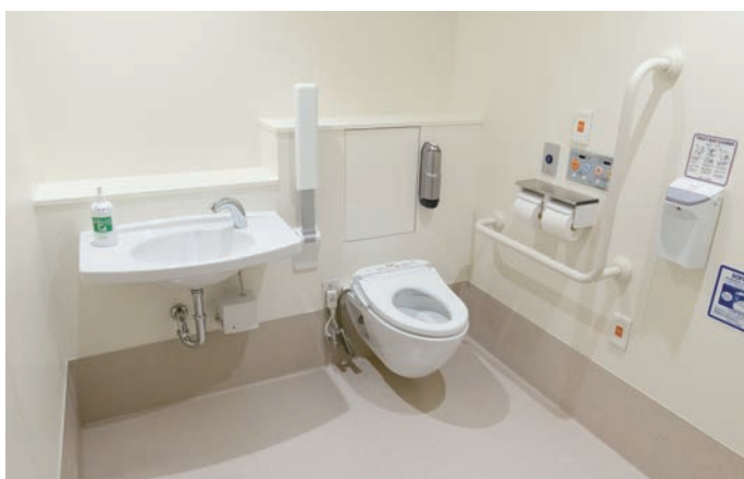
病棟の車いすトイレ。壁掛けタイプの便器やはね上げ手すり、L型手すりを採用している。
