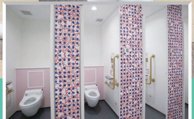
公立陶生病院 東棟 彩りも鮮やかで快適な外来のトイレブース
