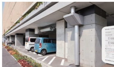
上:北東からの外観。生涯学習センター(メディアパーク市川)とリンクした煉瓦スクリーンが東・西面のファサードを彩る。左:地震時のBCP(事業継続性)を考慮し、上階を支える1Fの柱頭部には免振装置が設置されている。
