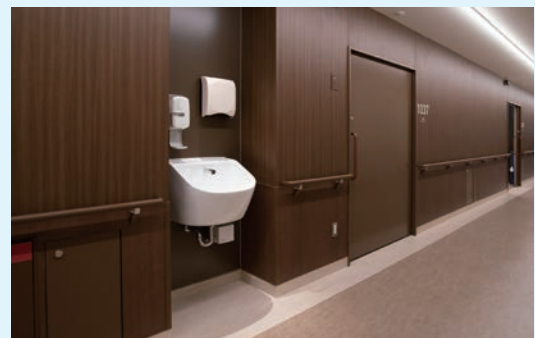
廊下の要所に設置されている手洗器。スタッフと患者兼用であり、病棟の共通仕様となっている。
