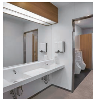
車いすでも使いやすい、1F男性用トイレの非接触タイプの手洗器。
