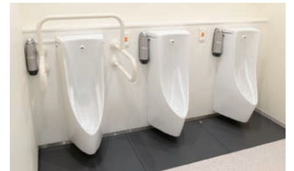
2F外来の男性用トイレには、防汚防臭陶板を採用。小便器にも清掃のしやすい壁掛けタイプを採用している。
