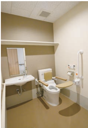
移乗や座位の安定のために、前方ボードや背もたれ付きトイレ用手すりなどが備えられたユニットの共用トイレ。
