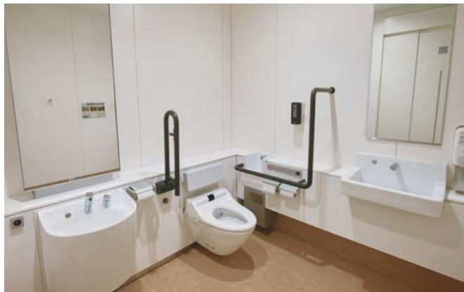
内視鏡検査室専用トイレの一つには、オストメイトのための設備も備えられている。
