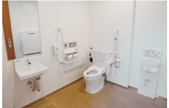
1Fの多機能トイレ。扉は自動ドアで、はね上げ手すり、L型手すり、背もたれを設置。おむつ交換台やベビーチェアなども設けられている。
