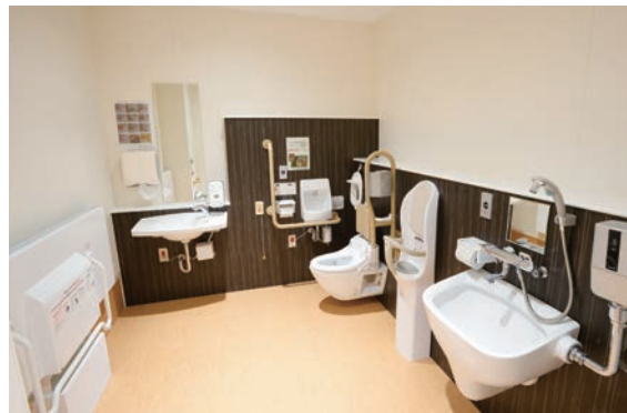
1F外来の多機能トイレには、子ども連れやオストメイトのための設備などが設けられている。
