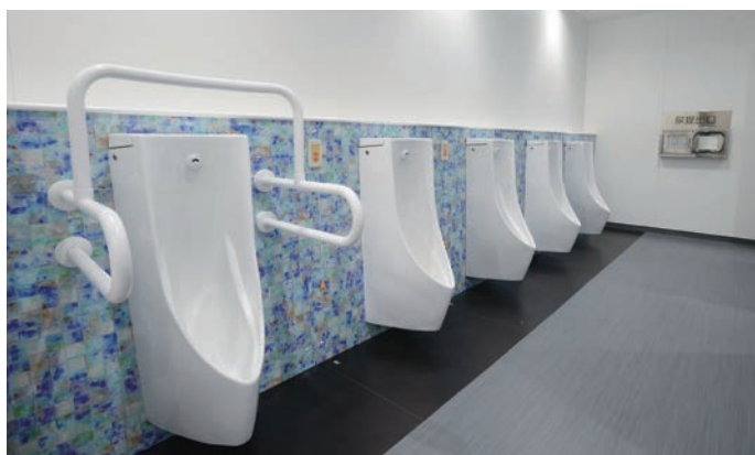
1F外来の男性用トイレの小便器。つまずき防止のため防汚防臭陶板とフロアの段差をなくしている。
