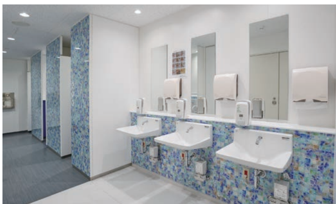
1F外来の男性用トイレの手洗器。ブースやライニングのデザインのメリハリが効いている。
