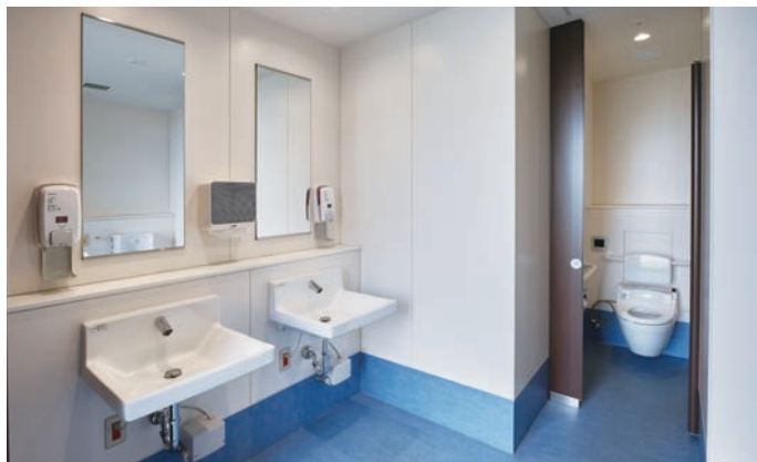
1Fの男性用トイレ。トイレブース内には壁掛けタイプの大便器や、背もたれ、L型手すりを設置している。
