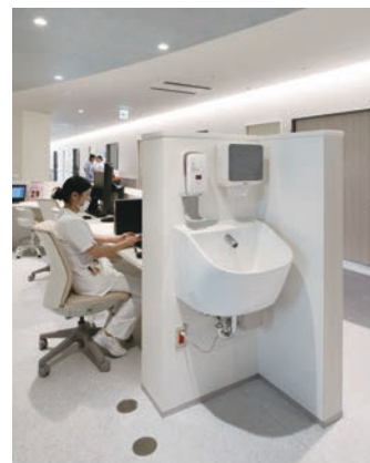
スタッフステーションの入口に設けられた、水はねの少ないスタッフ用手洗器。
