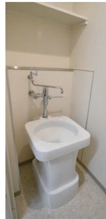
浴室前に設けられた手洗器と汚物流し。スタッフの動線を短くすることを考慮し、脱衣室、洗濯室、汚物処理室を一体化している。
