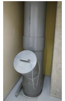
各脱衣室にはダストシュートを設け、ゴミ出しにかかる時間を削減。人手が足りない夜間にゴミを捨てに外へ出るスタッフの姿を見ながら、少しでも効率化できないかと考えた取り組みである。
