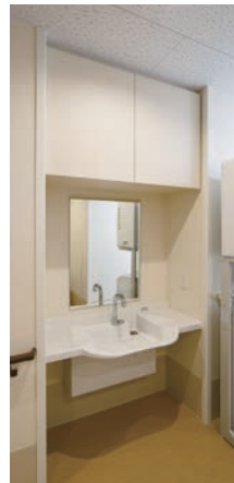
浴室前に設けられた手洗器と汚物流し。スタッフの動線を短くすることを考慮し、脱衣室、洗濯室、汚物処理室を一体化している。
