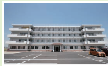
鉄筋コンクリート造、4階建ての建物。1Fには地域交流センターも設けられている。
