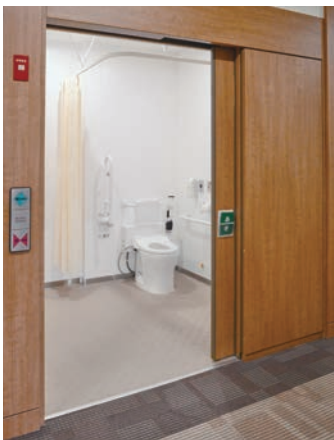
整形外科病棟2Fの車いすトイレ。介助する人がドアを閉めた時に施錠できないため、「あき」「使用中」という札を作って外の人に知らせている。
