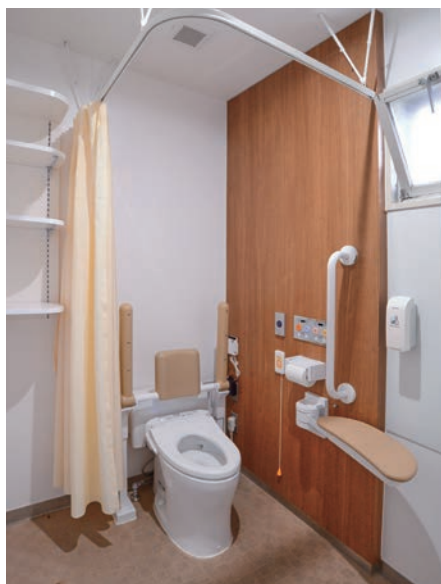
カーテンで仕切れるトイレブースには、スイングタイプ前方ボードやはね上げ手すり、背もたれなどが備えられている。
