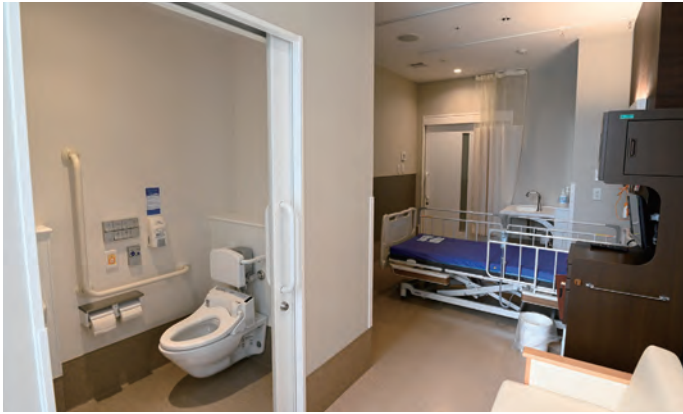
トイレを奥の窓側に設置したレイアウトの個室。トイレには背もたれ、L型手すりが備えられている。
