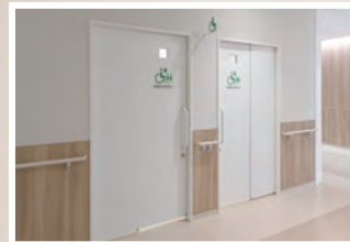
左右勝手に配慮した反転タイプの多機能トイレを並べ、患者さんに合わせて対応できる。
