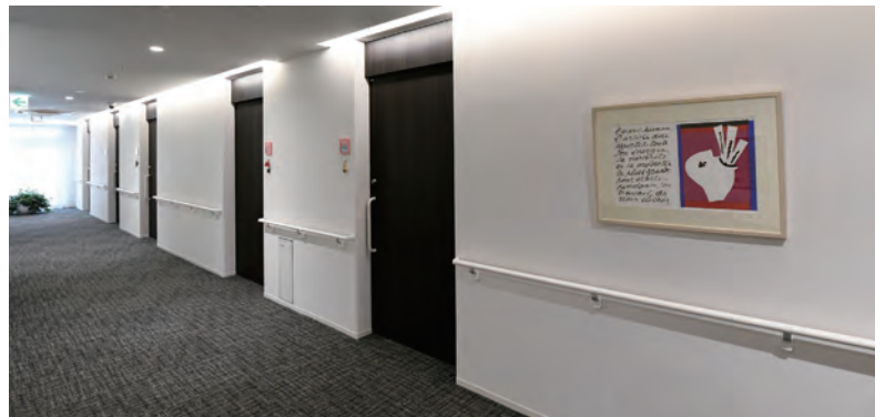
3Fの居室の並び。ドアはフレームをなくして少し奥に設置することで目立たないようにデザインされ、すっきりした印象の廊下になっている。
