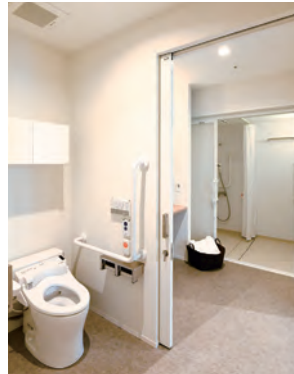
2人部屋はウォークスルーの水まわり設計。トイレにはL型手すりやはね上げ手すりを用意。
