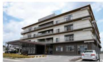
閑静な環境にある4階建ての施設。特別養護老人ホームやデイサービス、ショートステイなどの機能がある。
