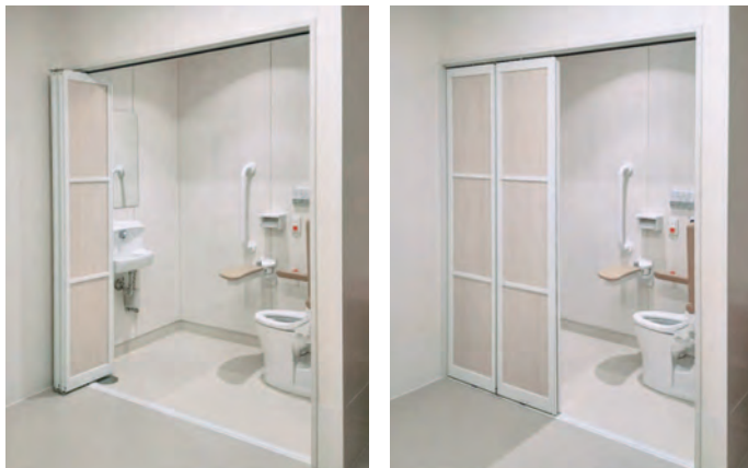
浴室の脱衣室にあるトイレの扉は、折戸で全開が可能であり、引き違いで前方からも後方からもアプローチできる。
