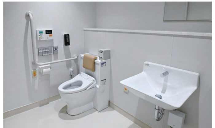
1F外来の泌尿器科に設けられたトイレ。背もたれやL型手すり、尿流量測定装置が設置されている。
