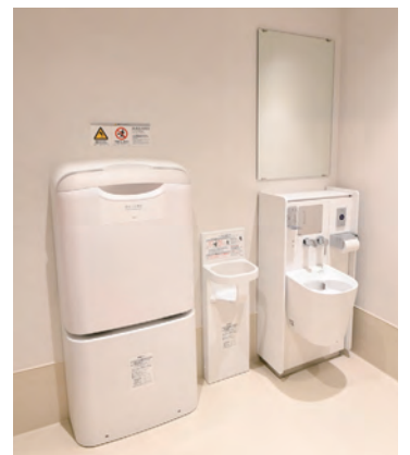
1F外来の多機能トイレには、オストメイトのための設備や、ベビーチェア、おむつ交換台などを設置。ナースコールの位置なども細かく検証された。
