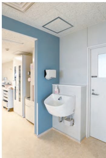
病棟のスタッフステーションの出入口に設けられた、水はねが少なく肘まで洗えるスタッフ用手洗器。
