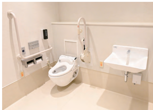
1F外来の多機能トイレには、オストメイトのための設備や、ベビーチェア、おむつ交換台などを設置。ナースコールの位置なども細かく検証された。
