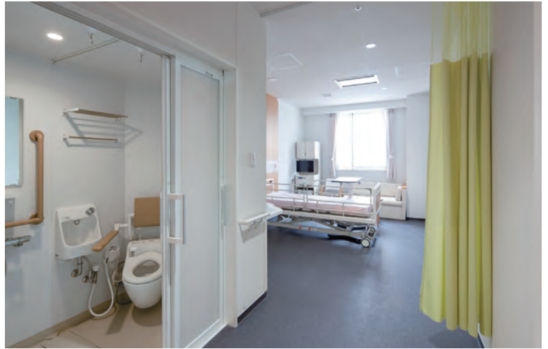
4F病棟の、8角形のトイレ・シャワーユニットのある病室。トイレには、はね上げ手すりや背もたれが、シャワー周りにはL型手すりなどが備えられている。*
