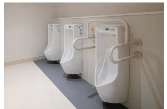
1F外来の男性用トイレ。小便器も壁掛けタイプであり、清掃しやすい。*
