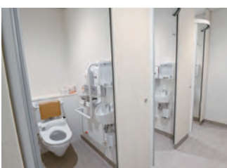
アール型扉のトイレブース内には、背もたれやL型手すり、手洗器などが設置されている。
