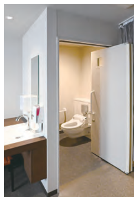
個室のトイレの扉には、押しでも引き、引いても開く、2方向に開閉するスライドドアを採用。患者さんの状態によって使い分けができる。
