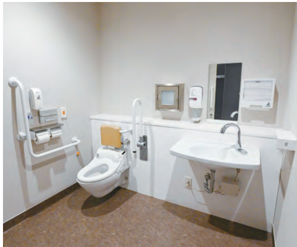
車いすでも使いやすい、十分な広さを確保した採尿用トイレのブース。はね上げ手すり、背もたれ、L型手すりが備えられている。
