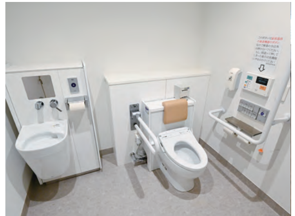
2F泌尿器科に設けられた検査用トイレ。尿流量測定装置や、オストメイトのための設備などが備えられている。
