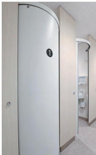
内視鏡センターの前処置室に設けられた、アール型扉の省スペースのトイレブース。
