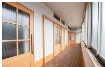
宿泊室の避難経路を確保し、法規制に対応するためにも設けた屋内テラス。用途変更による設計上の苦労も多かった。
