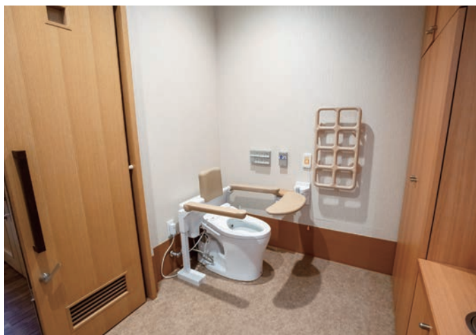
スイングタイプの前方ボード、はね上げ手すり、背もたれ、格子状の手すりなどが備えられた共用トイレ。格子状の手すりは体格に合わせて使いやすいというメリットがある。
