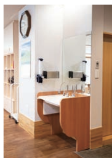
エントランス横に新設した手洗い器。利用者が訪れた際に、すぐに手洗いを行う習慣が付いた。
