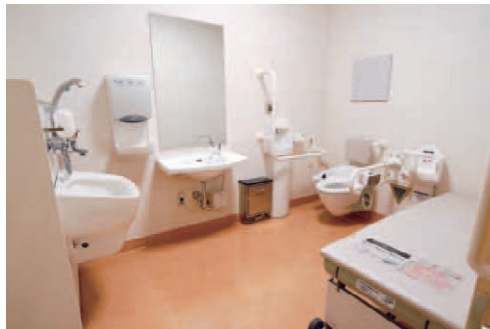
外来エリアの多目的トイレ。便器右側の壁に逆三角形の排気口が見える。
