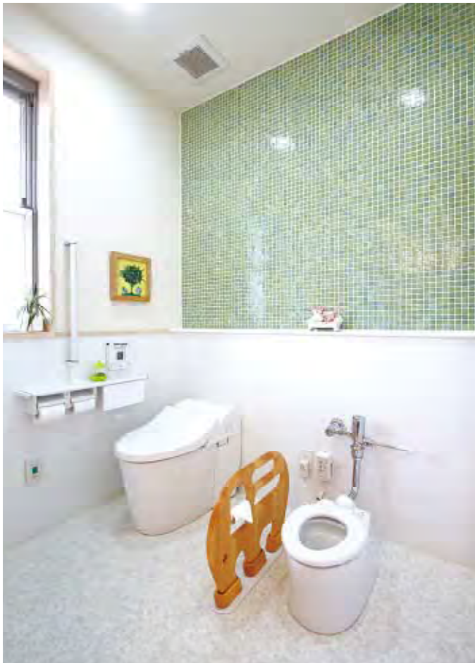
広くて明るい親子トイレ。タイル貼りの壁も美しい。足を床につける幼児用便器を採用しているため、早期の「トイレ・トレーニング」の場にもなっている。
