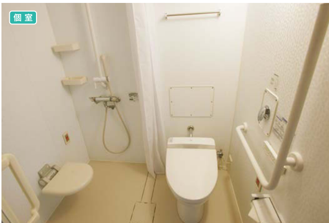
個室のトイレ・シャワーユニットには、L型手すりやI型手すりのほか、シャワー時に腰掛けられる、跳ね上げ式のツールも設けられている。
