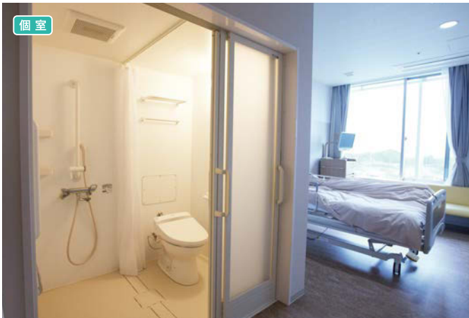
個室のトイレ・シャワーユニット。急性期医療が中心であるため、特別室以外には浴槽を設けずシャワーのみとしている。
