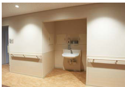
廊下をセットバックさせて設けられた、通行を妨げない手洗器。看護師がスタッフステーションまで戻らなくても手洗いができる。
