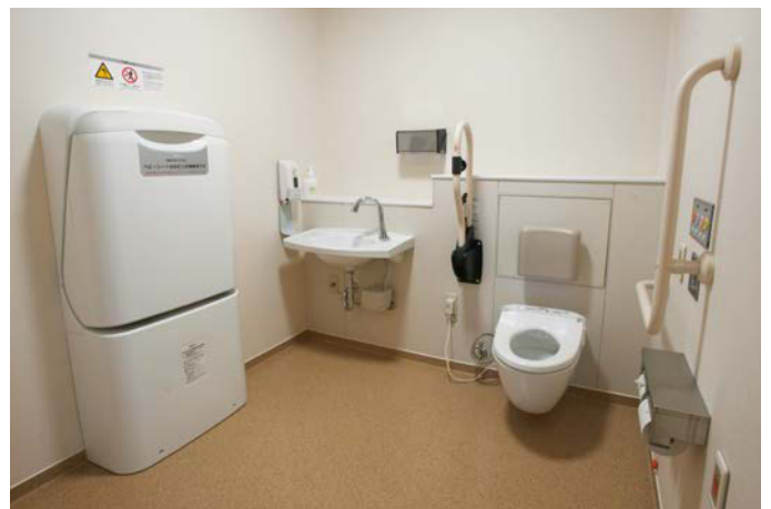
小児病棟の多目的トイレ。跳ね上げ手すりやL型手すり、背もたれなどが設けられている。
