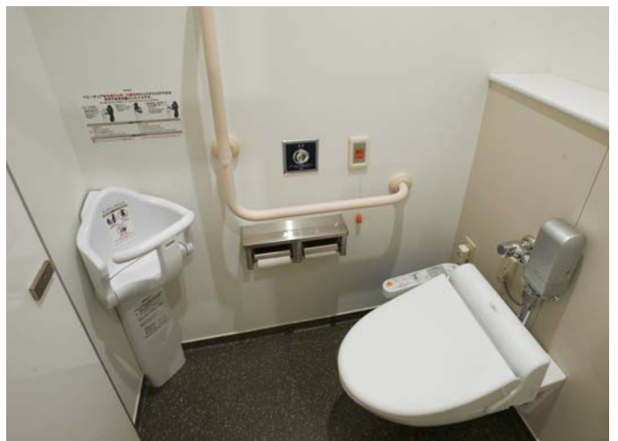
2F外來の女性用トイレでも、壁掛け大便器などを採用。ベビーチェアが設けられている。
