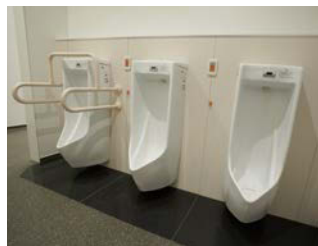
2F外來の男性用トイレでは、清掃のしやすい壁掛け小便器を採用している。
