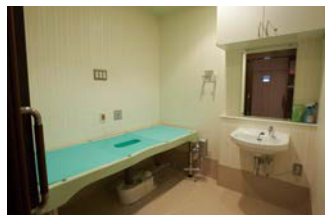
重度の身体障がい者など、座位がとれない人のために、「寝便座」の設備も設けられている。
