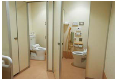
1Fの女性用トイレ。左右勝手どちらにでも対応できるよう、便器の向きが逆になっている。巻上巾木で清掃のしやすさにも配慮している。
