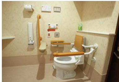
ユニットの共用トイレ。大便器の掃除口は車いすの足先に当たってしまうため、便器前方ではなく横の位置のほうがよいとのことである。
