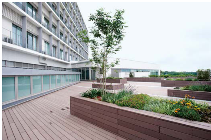
3Fのリハビリテーション室から続く屋外には、心地よいリハビリ庭園が設けられている。
