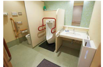
1Fの男性用トイレ。子どもも使いやすい壁掛式低リップタイプ小便器を採用し、洗面台の左右にも手すりを設けるなど、誰にでも使いやすい工夫が施されている。
