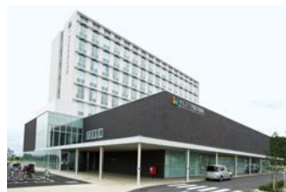
低層の1Fが外来部門で、2層吹き抜けの明るい日差しが入り込む空間となっている。
