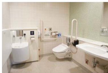
1Fの多目的トイレ。壁掛け便器はコンパクトで、広さを確保できるフラッシュバルブ式。巻上巾木などで清掃しやすい。
