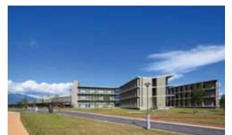
左側が外来棟と診療棟、右側が病棟である。
