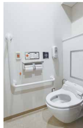
B1F男性用トイレのブース。大便器を洋式の壁掛けタイプに変更した。
