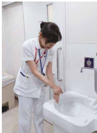
10F汚物処理室に設けられた汚物流し。作業性が向上し、腰にかかる負担も解消された。
