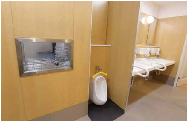
2F外来の女性採尿トイレには、幼児用小便器も設置。子ども連れの患者さんの立場を考えた、きめ細かな配慮である。なお、以前は1ヵ所設けられていた和式便器も洋式便器に改修された。
