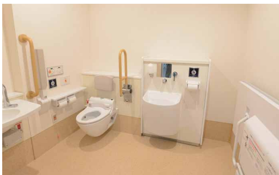
オストメイト対応の多機能トイレ。床材を巻き上げているので清掃しやすい。
