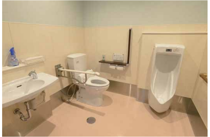
小便器も設けられた多機能トイレ。車いすの動きやすい広さを確保している。
