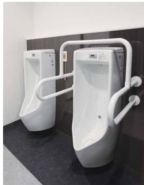
小便器の下には衛生性を高めるため、耐酸性のある長尺シートが敷かれている。
