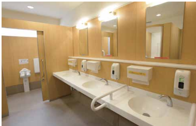
2F西の女性用トイレ。床材を巻き上げて巾木にしているため、清掃がしやすい。手すり付きの洗面カウンターも用意されている。
