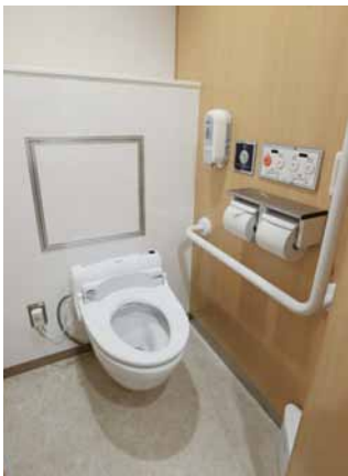
10Fの女性用トイレには、L型手すりなどが設けられている。
