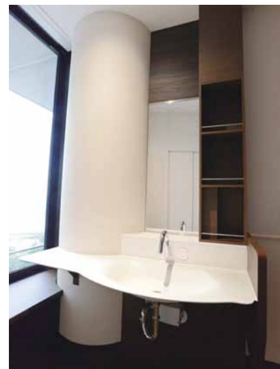
車いすでも使いやすい洗面台を、個室の窓側に配置。水栓が壁付けになっているので、水栓の付け根に水がたまず、衛生的である。
