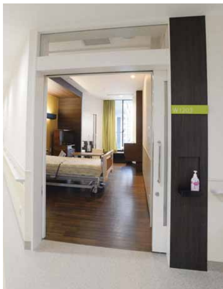
個室の出入り口。廊下の床材は巻き上げているため清掃しやすい。
