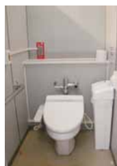
改修前のトイレ
