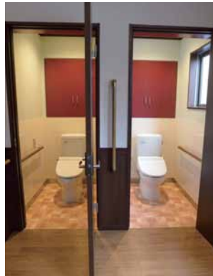
温かみのある、おしゃれなデザインの共用トイレは、左右勝手にも配慮している。空間が広すぎないほうが、介護者が壁に寄りかかったりして介護しやすいというメリットもある。
