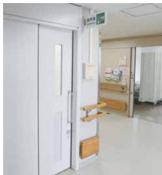
車いすでも使いやすい引戸を採用した多機能トイレ。サインはシンプルで分かりやすい。
