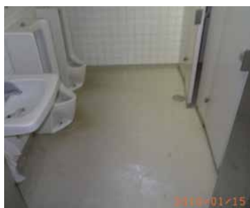
以前の小便器は床置きで、床が汚れやすいという問題もあった。
