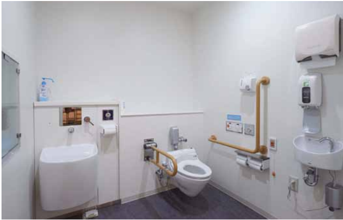
病棟1Fに設けられた、オストメイトに配慮した多機能トイレ。採尿用の窓のほか、跳ね上げ手すり、L型手すりなどが設けられている。
