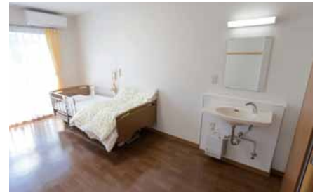
ユニットの個室。センサー式の手洗器は、すぐに湯が使えて快適に利用できるように電気温水器付きになっている。
