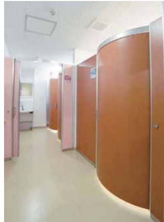
改修された3F A病棟のトイレ。女性用トイレの出入口にもアール型扉が設けられている。
