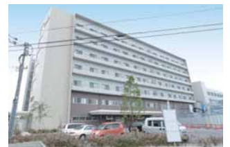
旧棟の隣に、新たにタワー棟が建設された。
