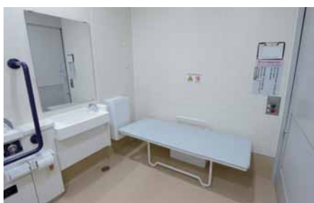
1F外来の車いすトイレの入口。人感センサー式のLED照明を採用している。
