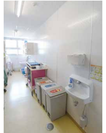
3F A病棟に設けられた汚物処理室。出入口近くに手洗器、奥に汚物流しが設置されている。
