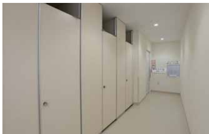
2F女性用採尿トイレ。車いすが通れる通路幅を確保し、いちばん奥に車いす用のブースを設けている。
