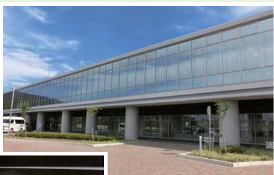
▲市立奈良病院 外観
