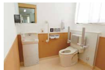
デイサービスの車いすトイレでは、座位の安定をはかる背もたれ付きアームレストを採用。
