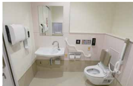
2F女性用採尿トイレ内の、奥に設けられた車いすトイレ。背もたれ、跳ね上げ手すり、波型手すりなどが設けられている。
