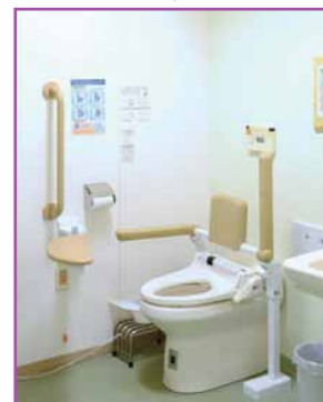
前方ボード(スイングタイプ)+背もたれ付きアームレスト
