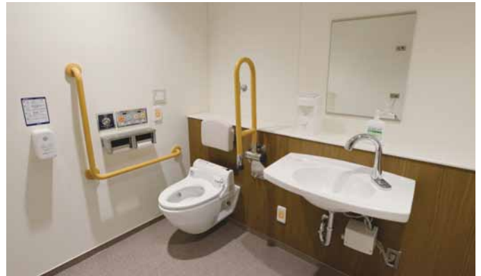
病棟トイレ。最初に、見えづらい患者さんといっしょに看護師が入り、設備の位置を説明する場合もあるため、広いスペースを確保している。
