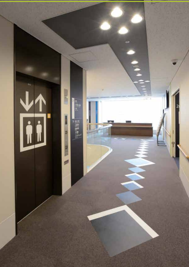
天井からの光も誘導灯であり、光の反射で際立つ床タイトルの白ライン矢印が進行方向を示す。
