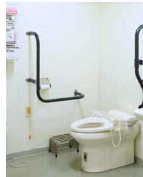
L型手すり+跳ね上げ手すり
