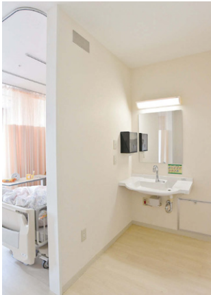
4床室の車いすで使いやすい洗面カウンター。
