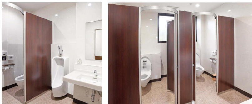
スタッフや来客用の男性用&女性用トイレも、アール型扉のブースに改修。便器はすべて壁掛けタイプを採用している。
