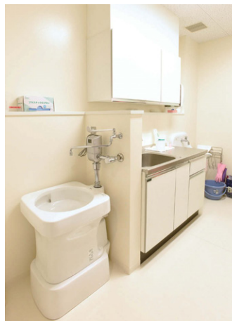
汚物処理室では、感染対策に配慮して非接触の汚物流しを採用している。
