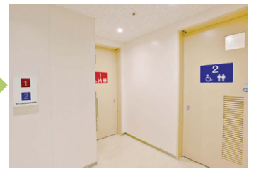
After 多機能トイレ出入口
