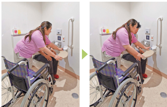
① 排便後に前方ボードを手前へスライドさせる。 ② 入所者さんの最適な位置に合わせてセットする。
