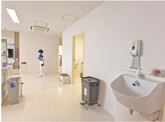
スタッフステーションの出入口に設けられた、深型の手首までしっかり洗える手洗器。
