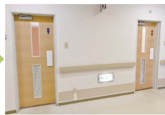
After 出入口外観とサイン
